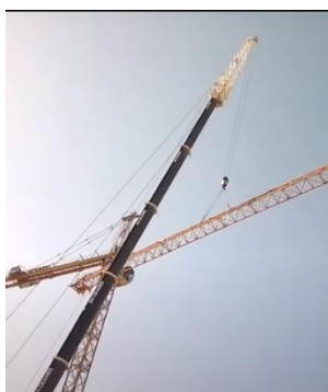
Установка балки противовеса
