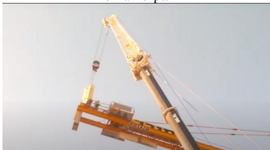
Установка противовесов
