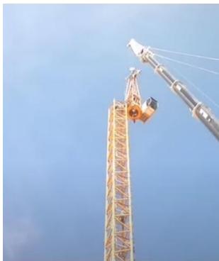
Установка оголовка
